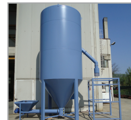
STAZIONE DI MISCELAZIONE E CARICAMENTO BIG-BAG LOADING AND MIXING BIG-BAG STATION
