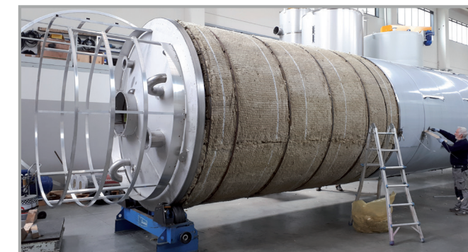
LAVORI DI COIBENTAZIONE SERBATOIO TANK INSULATION WORKS
