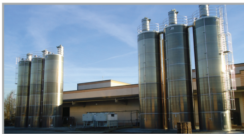
SILOS DI STOCCAGGIO PER POLVERI POWDER STORAGE SILOS
