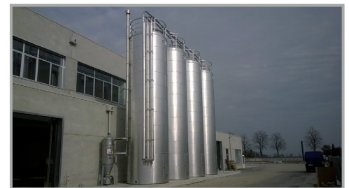
SILOS DI STOCCAGGIO COIBENTATI CON IMPIANTO DI FILTRAGGIO CENTRALIZZATO INSULATED STORAGE SILOS WITH CENTRALISED FILTERING SYSTEM
